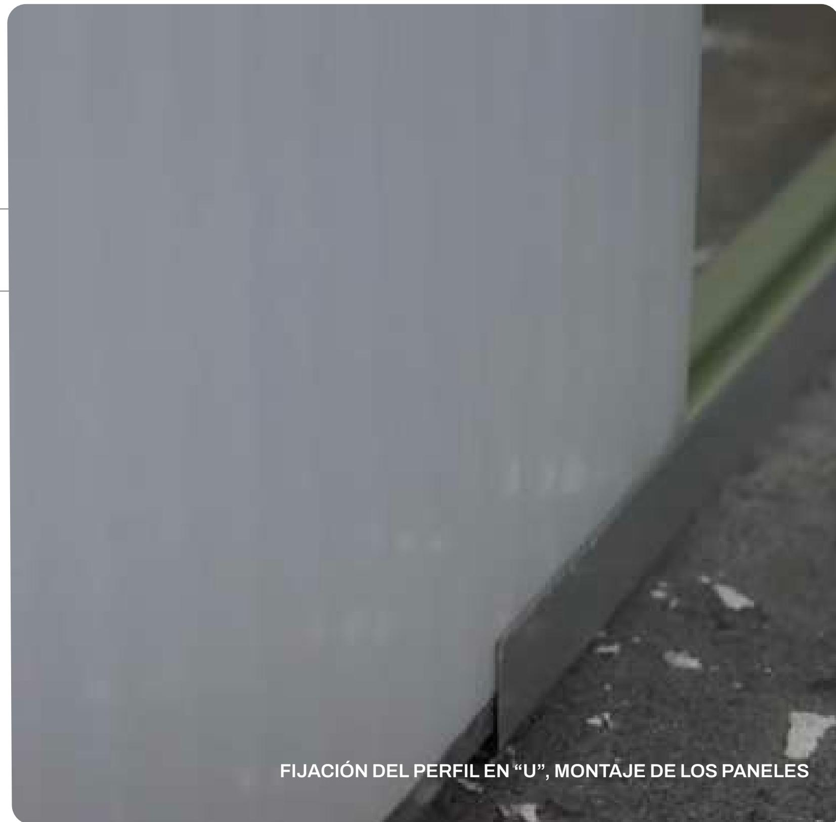
FIJACIÓN DEL PERFIL EN "U", MONTAJE DE LOS PANELES
