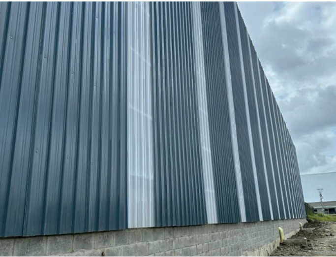
Centro logístico zona franca, Ekorooft , Colombia
