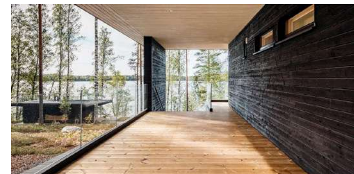
Casa privada, Thermowood deck, Finlandia
