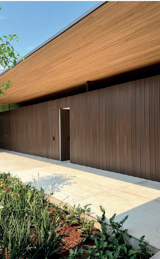
Casa PCD, Arkowood wallpanel exterior, Jacobsen Arquitetura Brasil
