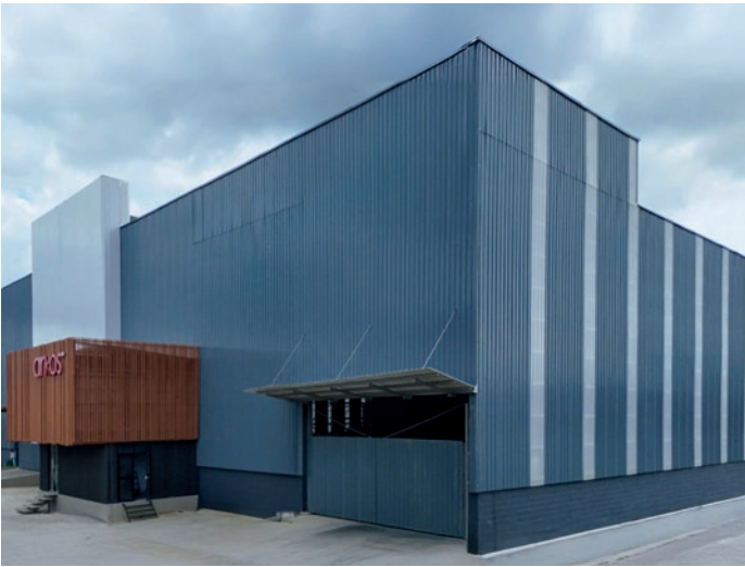
Centro logístico zona franca, Ekorooft , Colombia
