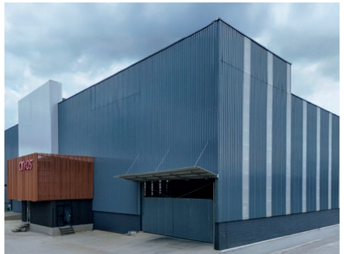
Centro logístico zona franca, Ekorooft , Colombia
