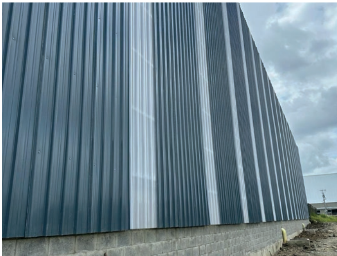
Centro logístico zona franca, Ekorooft , Colombia
