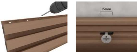
**B.** Se requieren perforaciones previas en la pestaña de cada Wallpanel®. El siguiente Wallpanel® se inserta en la pestaña del primero y se fija con tornillos.
